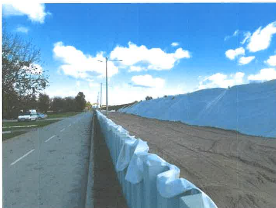
Slika 17. Radovi na modernizaciji savskih nasipa, pobijanje talpi u Slav. Brodu
