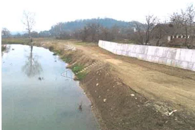
Slika 20. Izveden obrambeni zid na rijeci Orljavi od rkm 8+450 do rkm 4+510 u naselju Cigleniku
